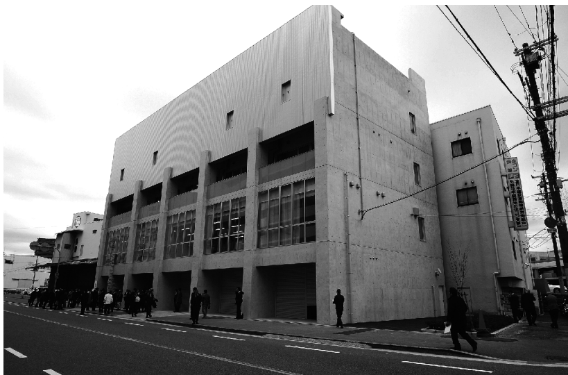
多くの協力で完成した学働館だが(2015年)
