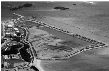
土砂投入が進む辺野古新基地
