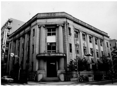
神戸市中央区旧居留地にあった旧内田汽船ビル。1919年築の同ビルは、阪神大震災で被災し解体された。
