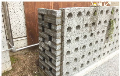
ポラスコンクリートブロックの積み上がり
