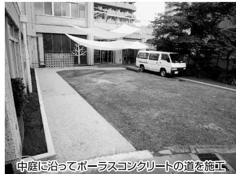
中庭に沿ってポーラスコンクリートの道を施工
