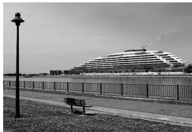
芦屋ベイコート倶楽部 新築工事 (神戸生コンクリート協同組合 神戸ブロック)
