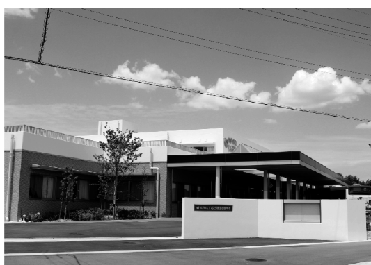
井吹台西町支援学校 新築工事 (神戸生コンクリート協同組合 神明ブロック)
